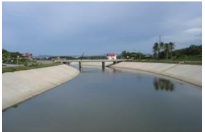
ภาพที่ 3-43 คลองระบายน้ำขนาดใหญ่
