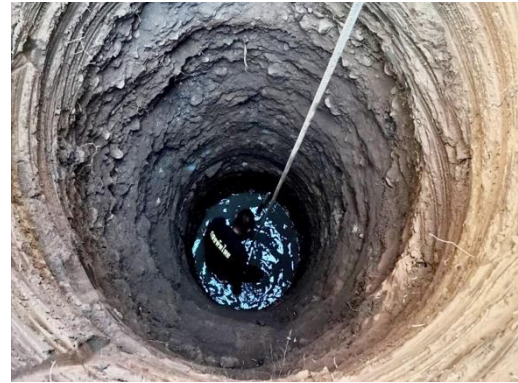
ภาพที่ 3-28 บ่อน้ำตื้น มีลักษณะเป็นบ่อที่ขุดลึกลง ไปต่ำกว่าระดับน้ำใต้ดิน ซึ่งมักจะลึกไม่เกิน 10 เมตรและมีความกว้างอยู่ระหว่าง 0.8 – 2 เมตร
