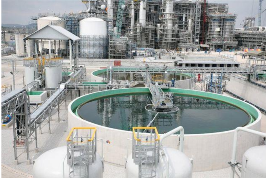
ภาพที่ 3-63 ระบบบำบัดน้ำเสีย
