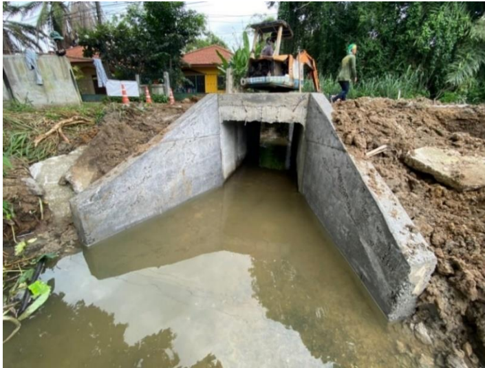
ภาพที่ 3-79 ท่อลอดระบายน้ำ (ทรบ.)
