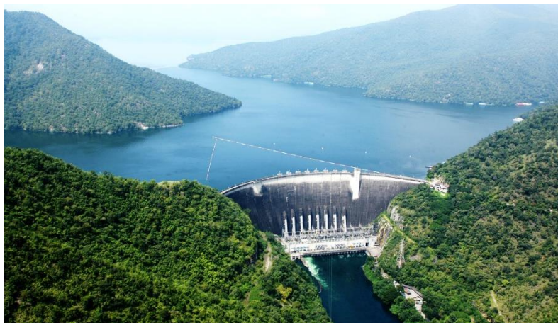
ภาพที่ 3-4 อ่างเก็บน้ำ
