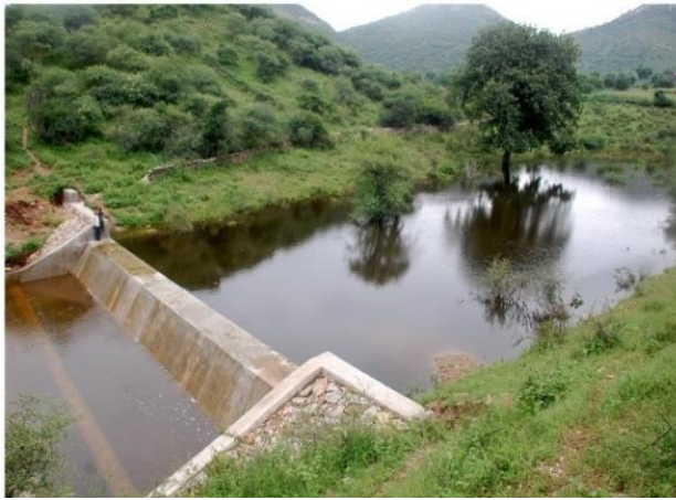
ภาพที่ 3-7 ฝายคอนกรีต
