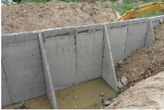
ภาพที่ 3-59 พนังกั้นดินแบบคอนกรีต
